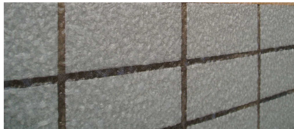
セブンス マスチックローラー塗り 中目2回塗り
