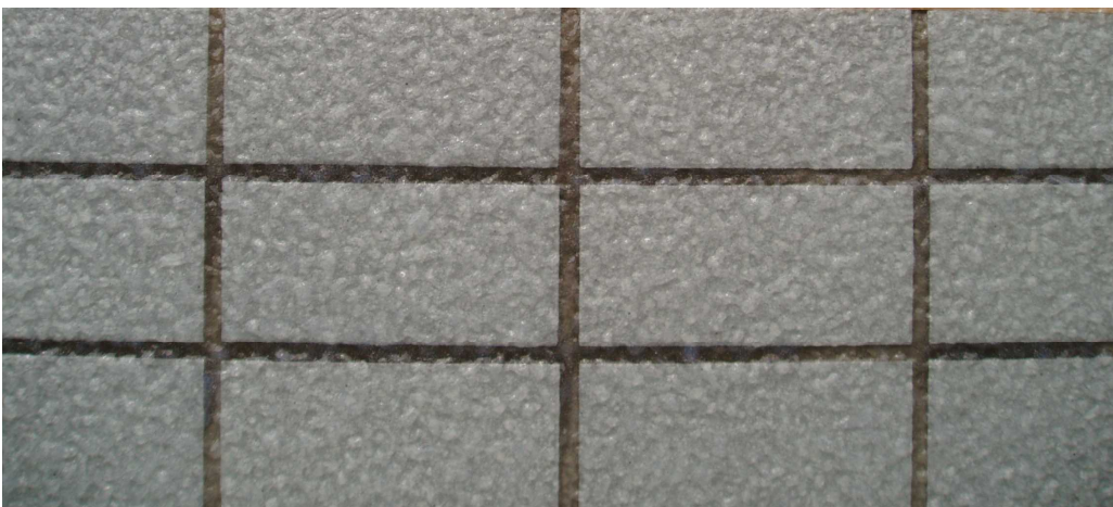
セブンス マスチックローラー塗り 中目2回塗り
