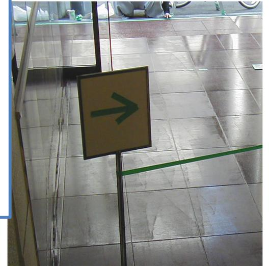
ローラーを一方向に伸ばすと骨材跡が白く残り、筋汚れになり目立ちます。
