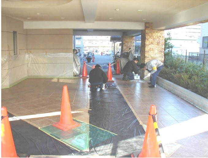
下地は、エフロ・油分・樹脂・を除去し、十分に乾燥させて下さい。
